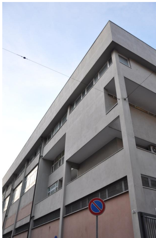
Figura 1.1 - Vista della facciata sud
