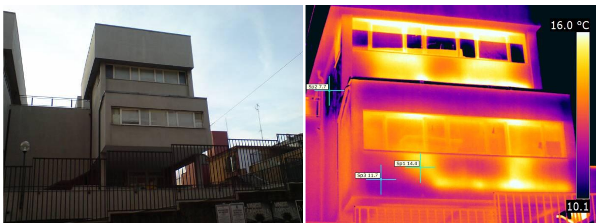
Figura 4.3 – Rilievo termografico della parete del fronte est (zona ingresso scuola media)
