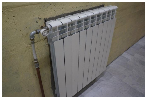
Figura 8.5 – Particolare terminali di emissione
